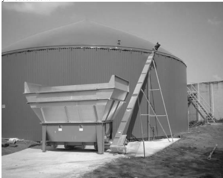
Rysunek 8. Przykład zbiornika wstępnego na substraty stałe z systemem dozowania (źródło: WWW.ieo.pl)
